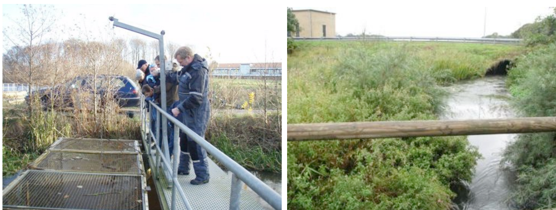
Figur 5 Fiskefælden (buret) tømmes hver dag for fisk i oktober, november og december, hvorefter de sættes ud i vandkraftsøen opstrøms dæmningen, så fiskene kan fortsætte vandringen. Egnede laksefisk stryges for æg og mælk i gydeperioden, hvorefter de opdrættede ungfisk udsættes i Storåen (Holstebro.dk).
