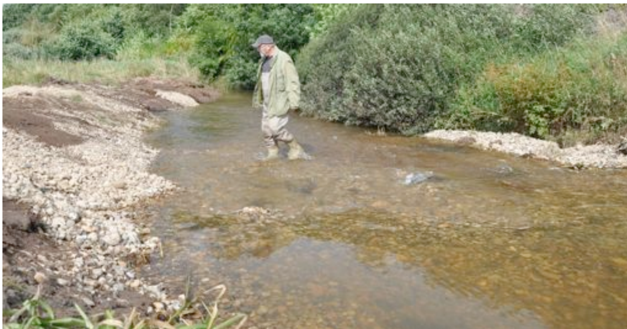
Figur 9 800 m 3 gydegrus er udlagt i september 2010 i Tvis Å ved Hingbjergvej. Foto: Klaus Balleby.
